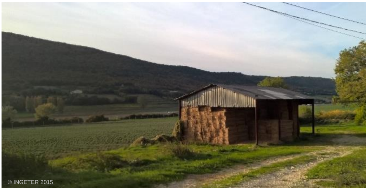
Figure 83: Entrepôt à foin, rue de la Coucourde
