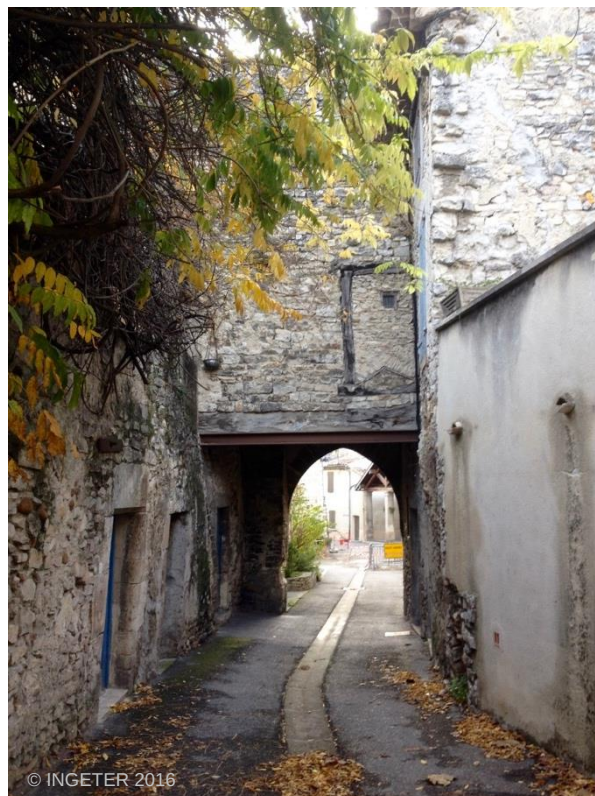
Figure 98: Façade orientale, vue vers le lavoir
