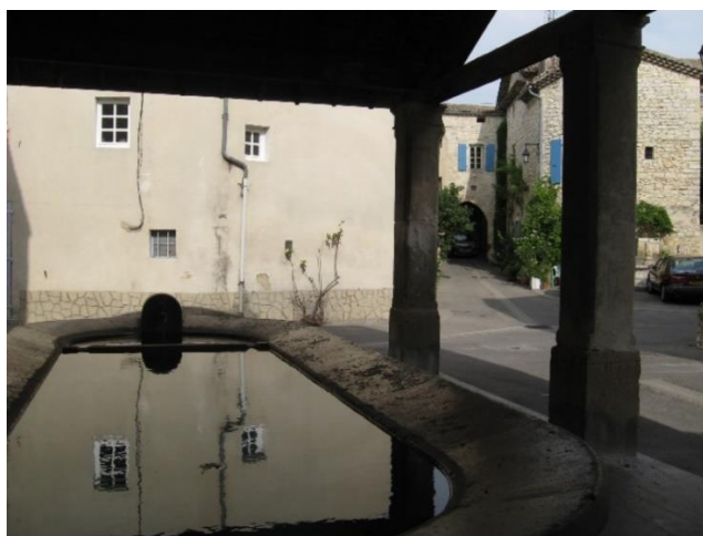
Figure 142. Lavoir de SAINT-MARCEL-LES-SAUZET en centre ancien (source : INGETER 2015)
