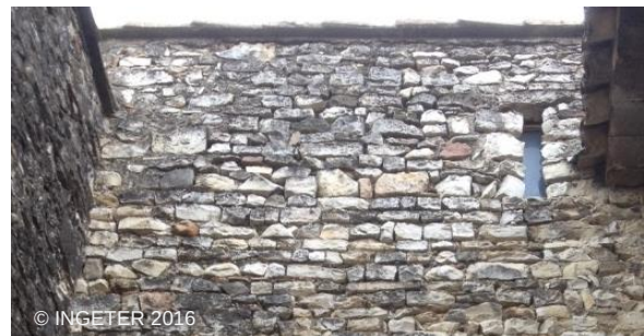
Figure 71: Maçonneries en limousinage, SAINT-MARCEL-LÈS-SAUZET
