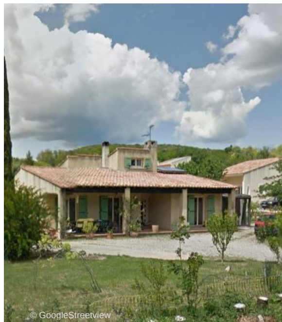
Figure 78: Pavillon en milieu de parcelle, route des Andrans
