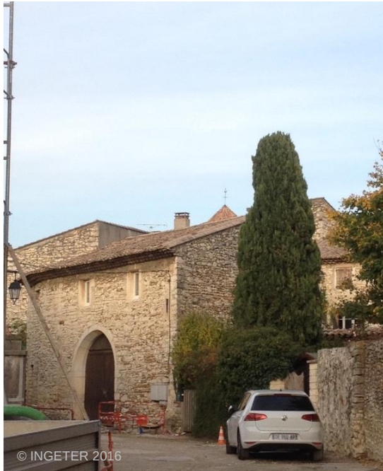
Figure 75: Ancien corps de ferme avec porte cochère, rue du Lavoir
