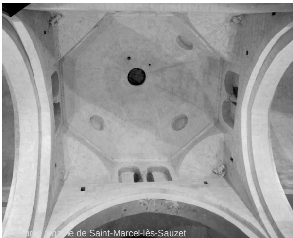
Figure 90: Vue de la coupole et des trompes sculptées
