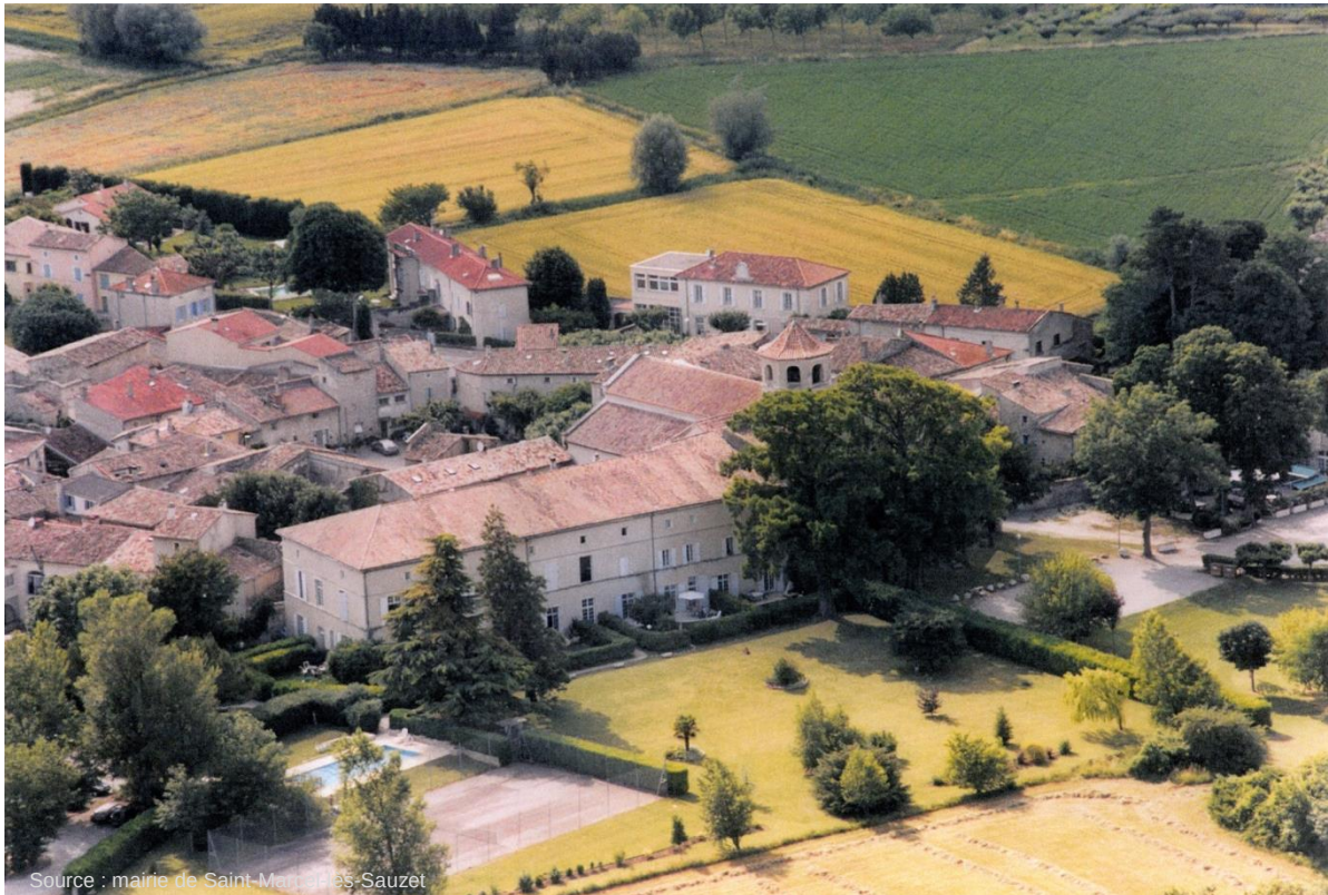
Source : mairie de Saint-Marcel-lès-Sauzet Figure 96: Les bâtiments du prieuré, transformés en logements en 1986. Extrait de carte postale.
