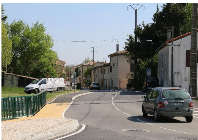
Figure 103 : Les travaux sur la RD 6 ont permis de sécuriser l'entrée de ville ouest
