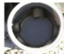
**Le regard de bouclage** : vérifier que le regard soit sec, une arrivée d'eaux usées serait signe d'un colmatage du système de traitement.
