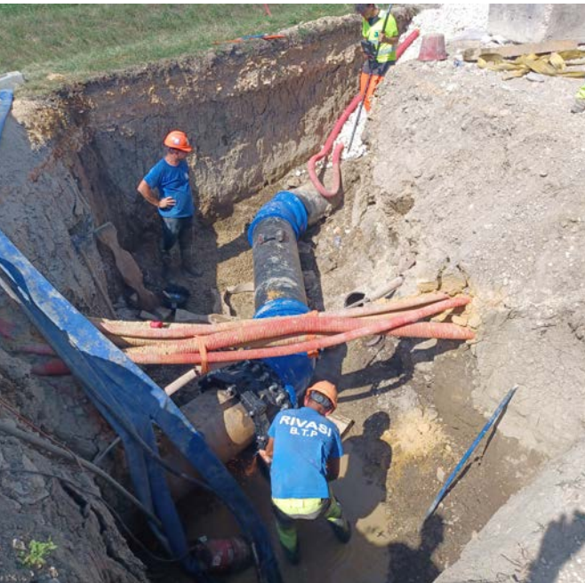
Des travaux nécessaires pour moderniser le réseau d'eau potable de l'Agglo.
