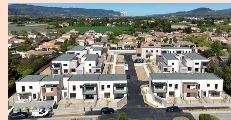
Inauguré le 9 octobre, le Domaine Gambus (44, vieille route du Teil) est composé de 40 nouveaux logements (11 T2, 22 T3, 7 T4) offrant confort, performance et qualité de vie à ses nouveaux habitants. Ce programme illustre pleinement l'engagement d'Orélia (ex-MAH) en faveur d'un habitat durable, accessible et respectueux de l'environnement.
